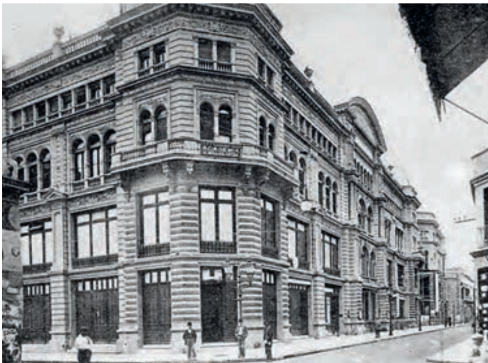
Fachada del Bon Marché, entre Florida y Córdoba. En el primer piso, funcionó la sede inaugural del Museo Nacional de Bellas Artes entre 1896 y 1910. Fotografía: Archivo del Centro de Estudios Históricos Ferroviarios, Museo Ferroviario.
